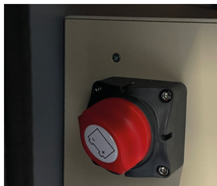
Figuur 5: de hoofdschakelaar is in deze positie uitneembaar
