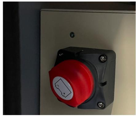
Abbildung 5: Der Hauptschalter ist in dieser Position entfernbar
